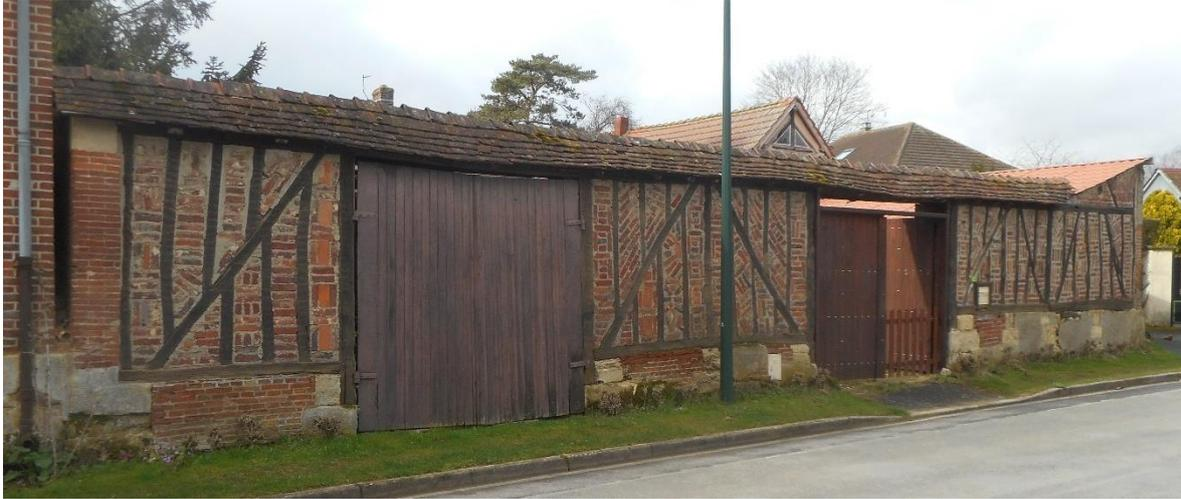
**Description** Mur en pans de bois comblés de briques maçonnées au mortier de chaux, surmontant un soubassement en briques et surmonté d'un chaperon de tuiles à deux pans.
