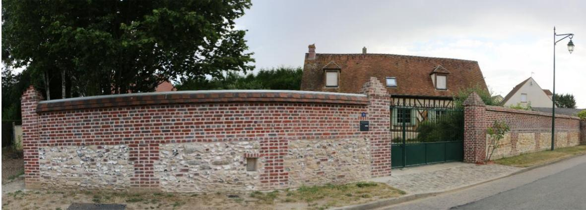
**Description** Mur en briques sur soubassement de silex, pierres et briques mêlés, avec chaînages en briques.
