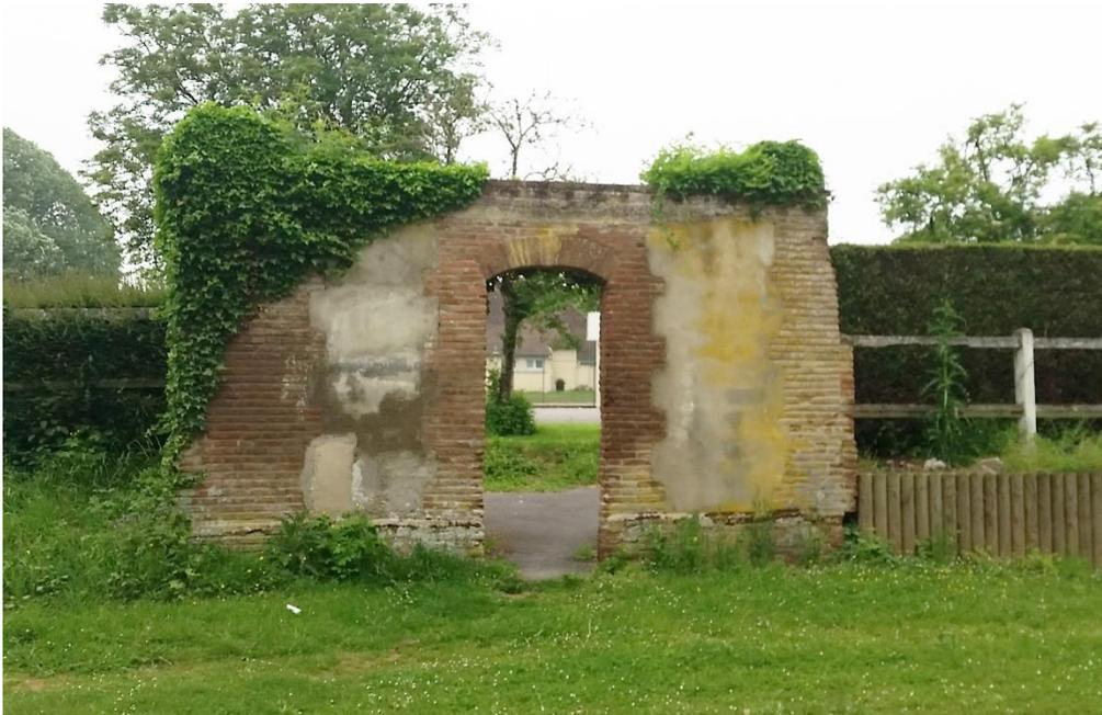
**Description** Porche composé de pierres et de briques d'une largeur totale d'environ 5 mètres. L'encadrement de la porte ainsi que les chaînages sont réalisés en briques. Les moellons de pierre constituant le mur ont été recouverts de ciment.
