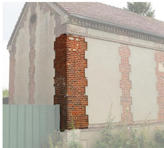
*Exemple de chaînage d'angle en briques
