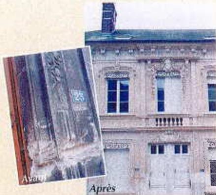
réparation et rejointoiment de la pierre au mortier de chaux
