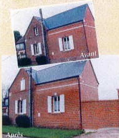
Dégradation des joints de brique et rejointoiment au mortier de chaux au nu du matériau + construction d'un mur de clôture en brique en continuité de la façade
