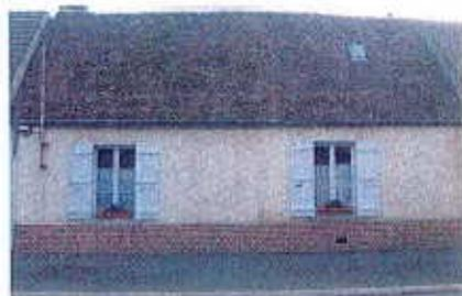
Ils sont parfois aussi en moellons à pierres vues liés au plâtre et jointés au mortier de chaux naturelle et de sable affleurant à la surface du mur. Les linteaux, encadrements, appuis de fenêtres sont en brique ou pierre.
