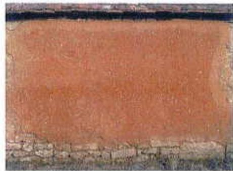
*Mur de clôture en torchis avec couronnement en tuile plate*
